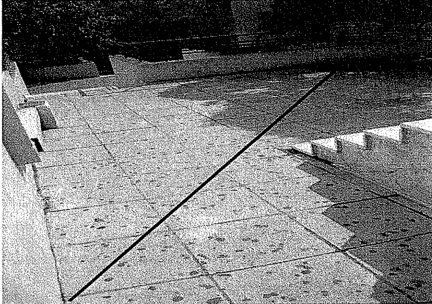
Εικόνα 15. Οριζόντια όδευση σωλήνα απορροής ομβρίων
